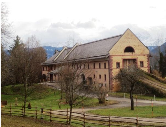
Wirtschaftsgebäude von Schloss Wasserleonburg
